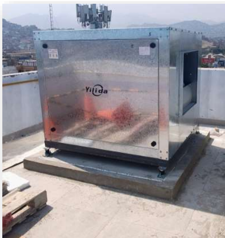
INSTALACIÓN DE EQUIPOS EVAPORADORES
