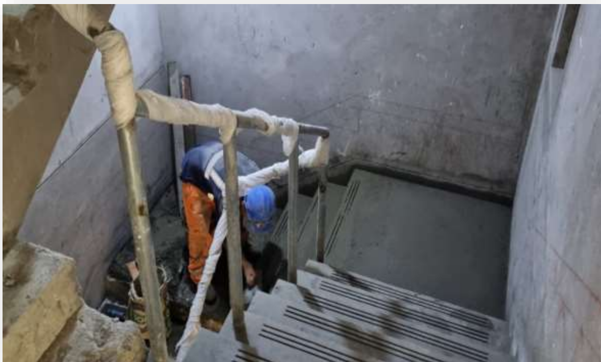
TARRAJEO DE ESCALERAS DE EMERGENCIA
