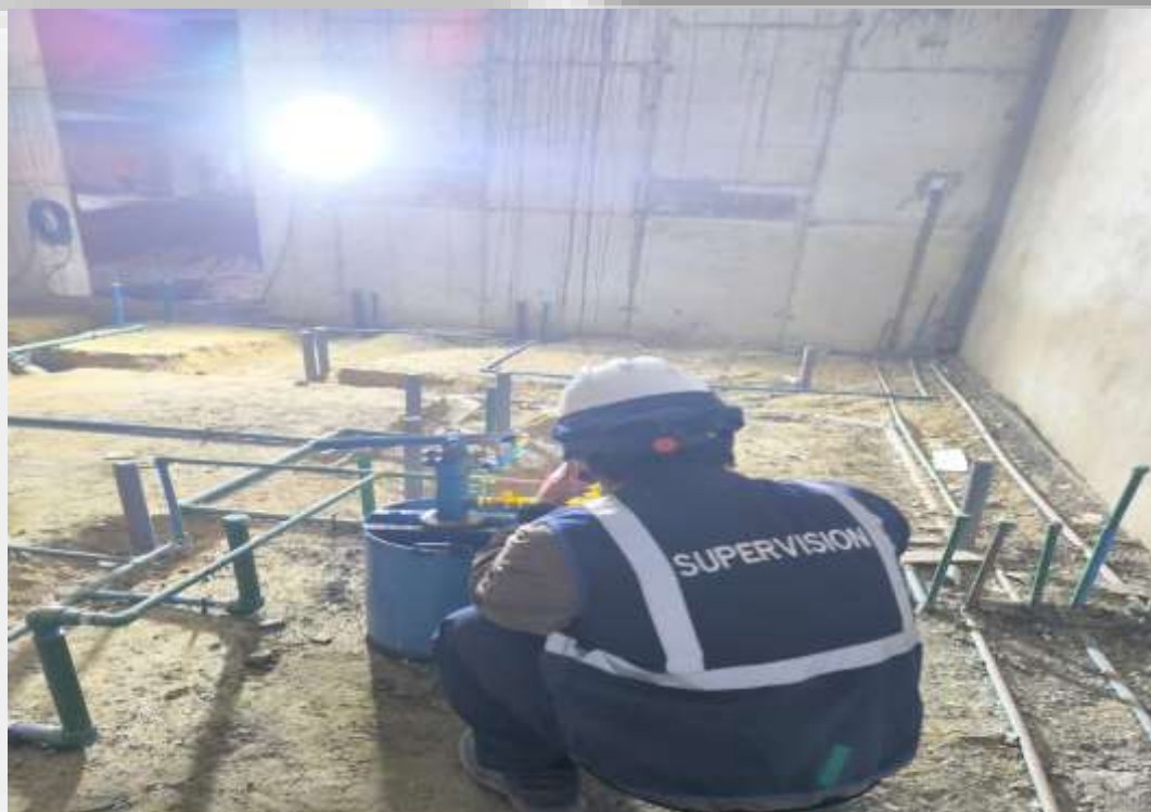
EJECUCIÓN DE PRUEBAS AMPERAJE DE POZOS A TIERRA Y PRUEBAS HIDRÁULICAS EN SSHH EN SÓTANO
