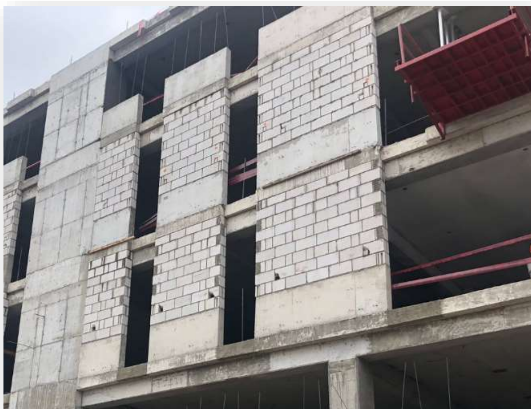
ASENTADO DE LADRILLO EN FACHADA 3ER Y 4TO NIVEL
