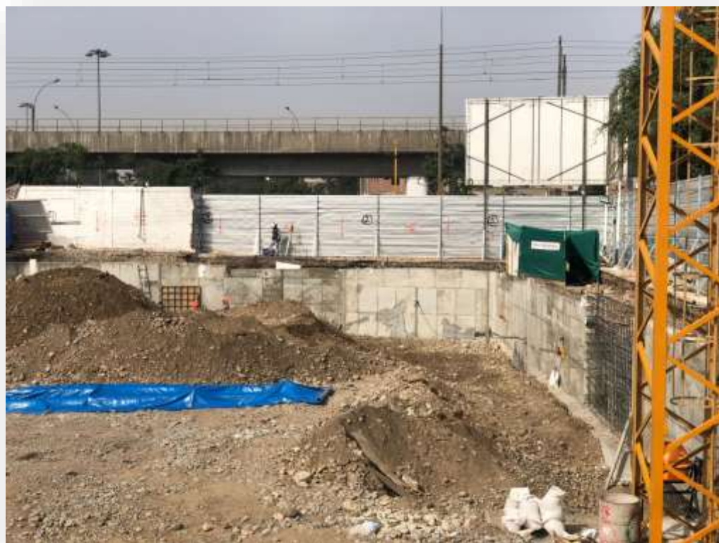
DESENCOFRADO DE MUROS PANTALLAS
