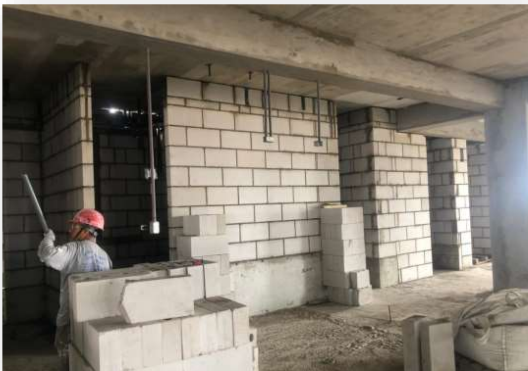
ASENTADO DE LADRILLOS EN 4TO NIVEL
