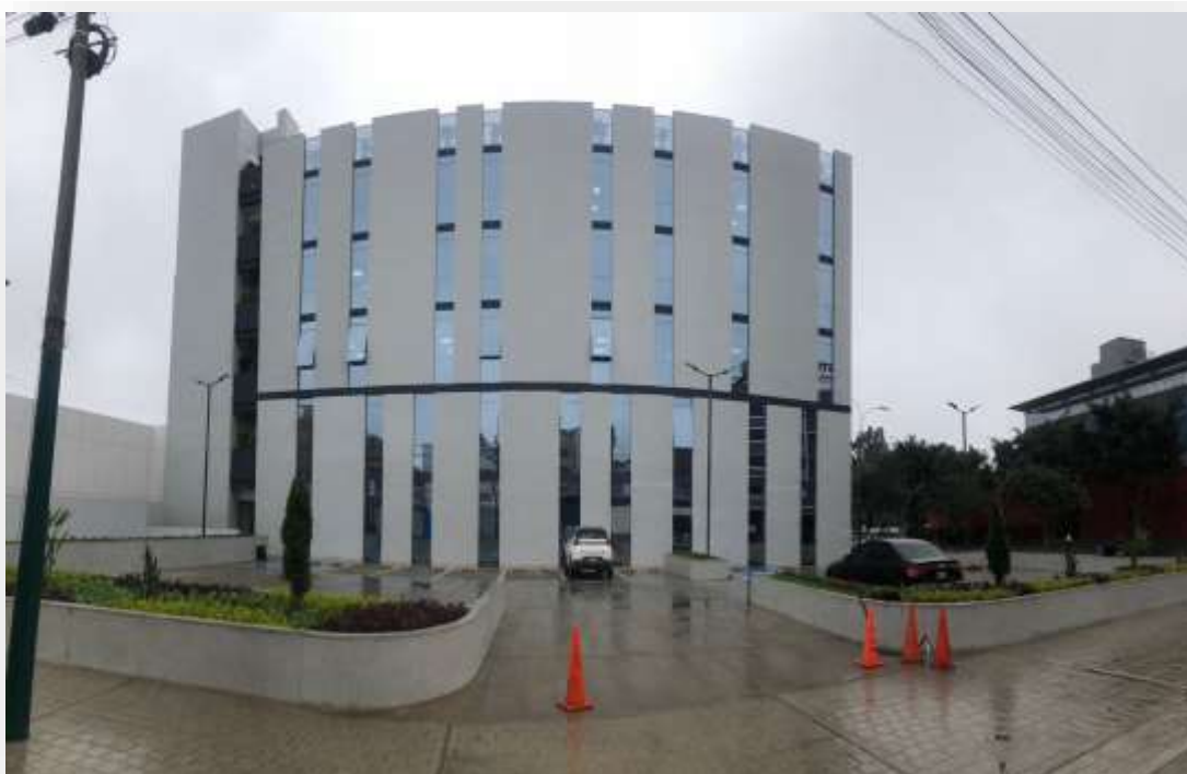
VISTA EDIFICIO DESDE JR. DE LOS CRISANTEMOS
