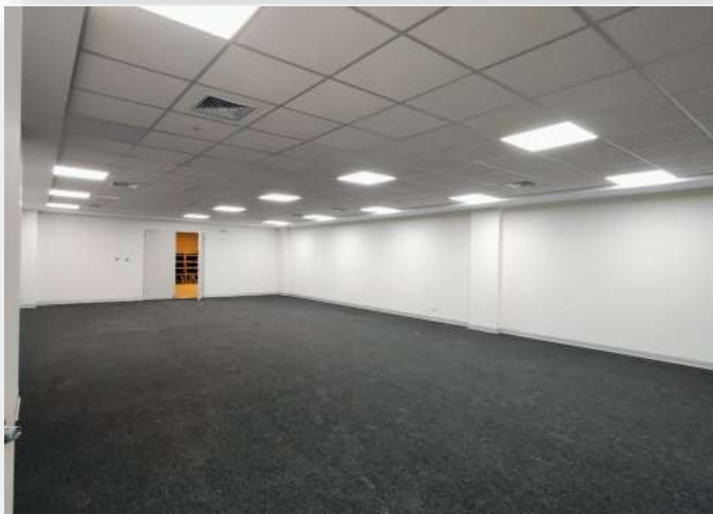
COLOCACIÓN DE PISO ALFOMBRA DE ALTO TRANSITO RESISTENTE AL FUEGO, INCL. ACCESORIOS
