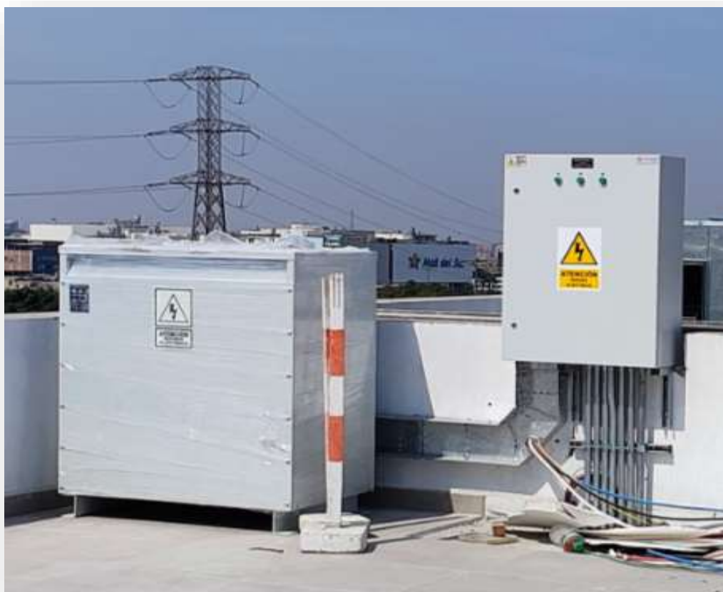
COLOCACIÓN DE TRANSFORMADOR Y TABLEROS EN AZOTEO
