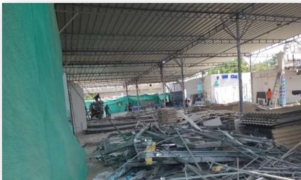
TRABAJOS DE RETIRO DE ESTRUCTURAS EXISTENTES EN ÁREA DE TRABAJO
