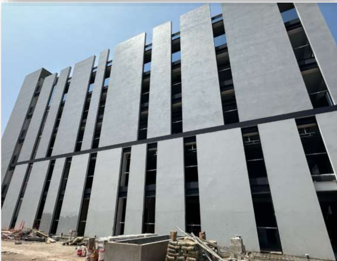
APLICACIÓN DE MICROTTEXTURADO EN FACHADA
