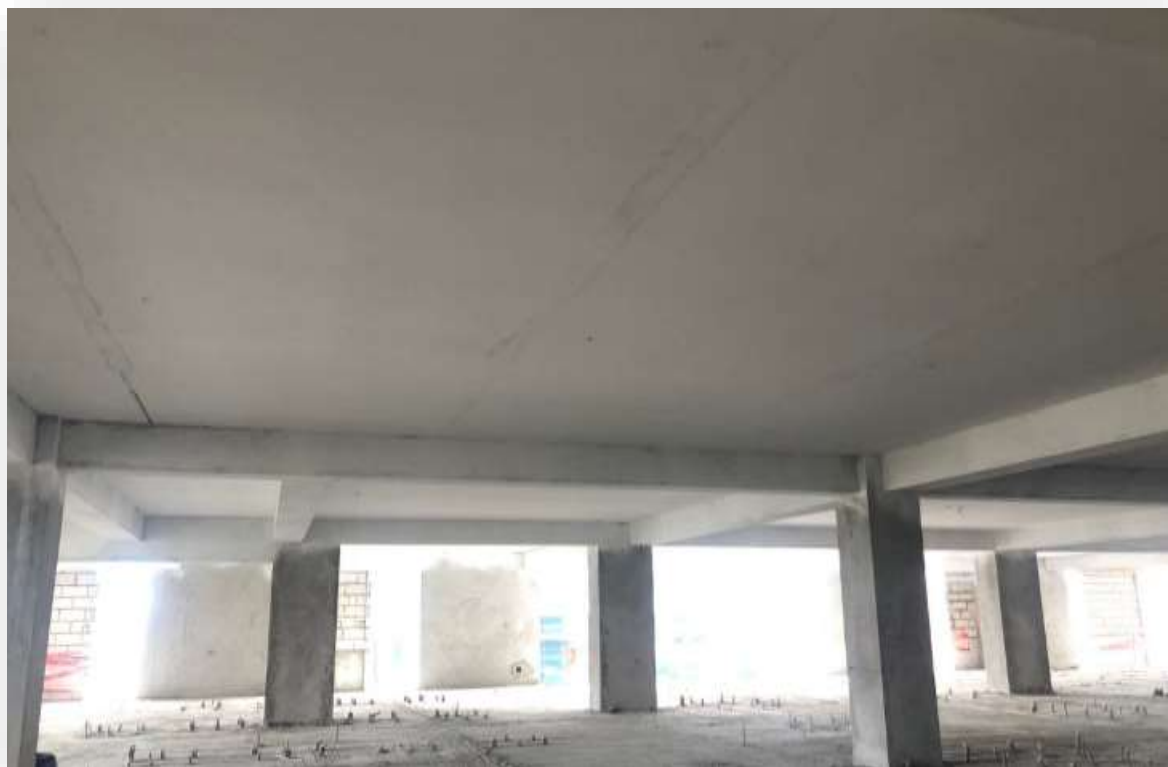
PINTADO DE CIELO RASO EN PRIMER NIVEL
