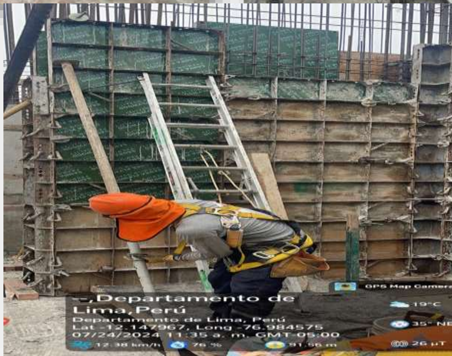
HABILITADO DE ACERO, ENCOFRADO DE COLUMNAS Y PLACAS
