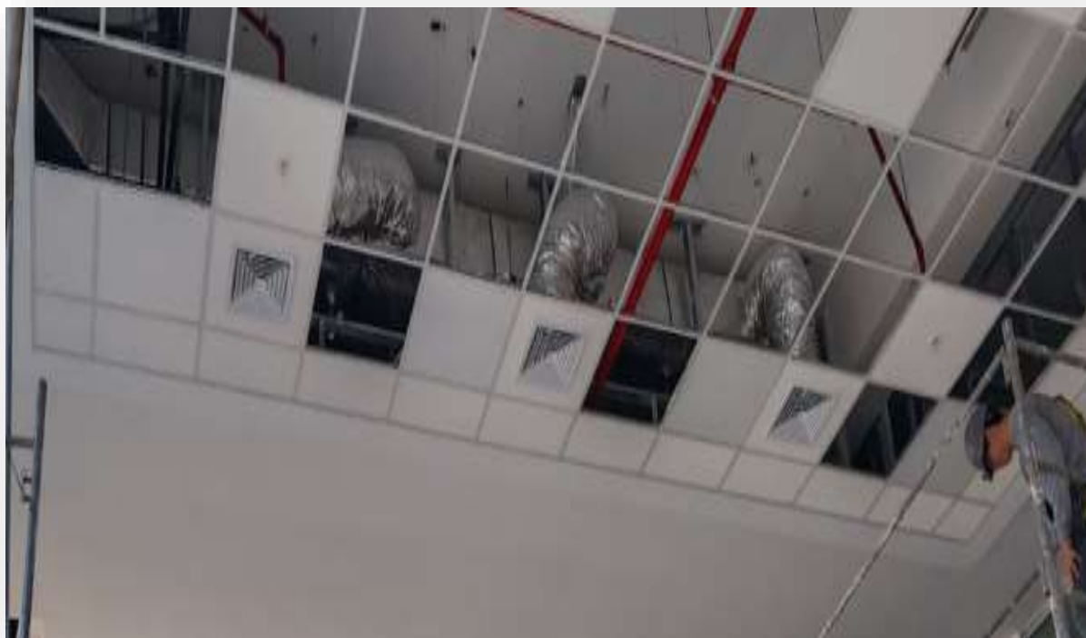
INSTALACIÓN DE MANGAS Y REJILLAS
