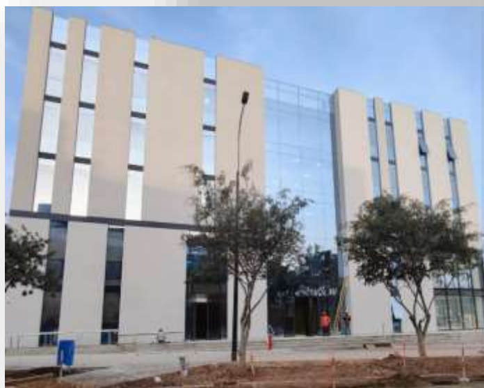
MURO CORTINA SISTEMA STICK CON VIDRIO TEMPLADO INCOLORO E=8MM
