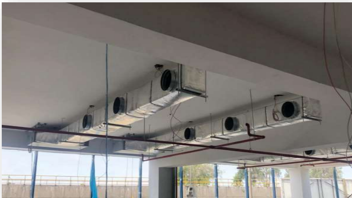
INSTALACIÓN DE EQUIPOS EVAPORADORES EN ZONA DE MONITOREO Y CONTROL
