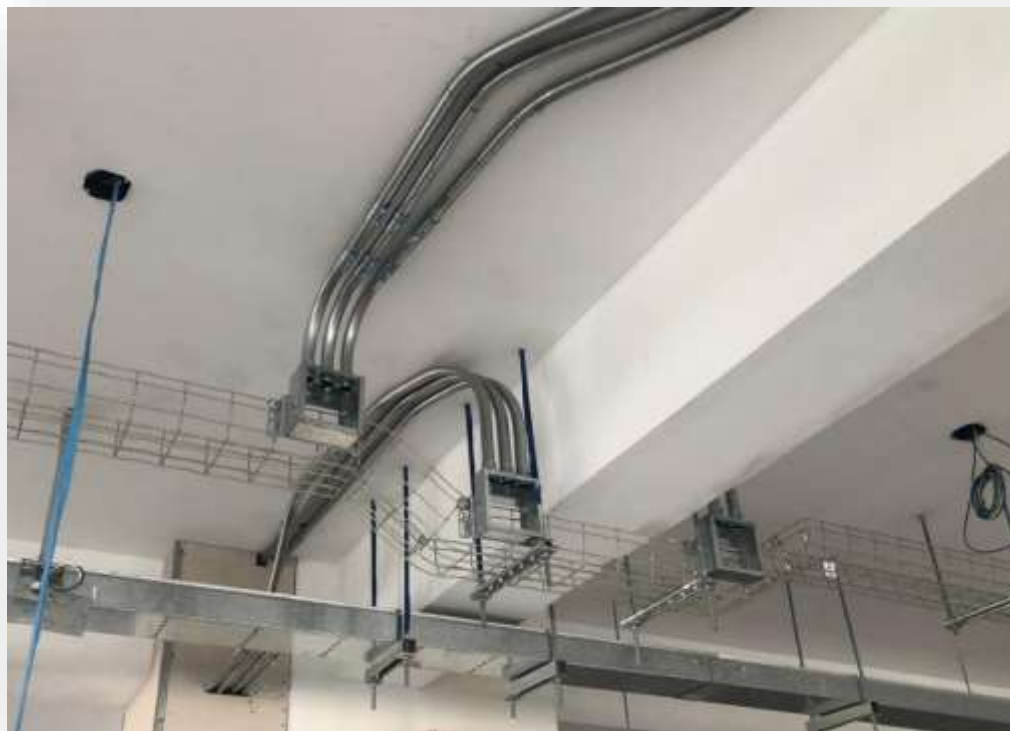
INSTALACIÓN DE TUBERÍAS EMT Y CAJAS DE PASO
