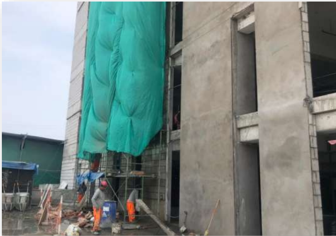
TARRAJEO DE FACHADA
