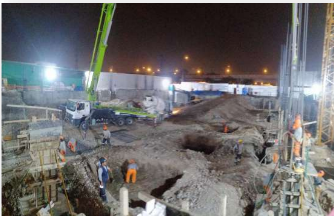
TRABAJOS DE EXCAVACIÓN PARA CIMENTACIÓN
