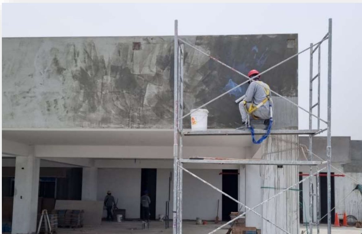
APLICACIÓN DE PRIMERA CAPA DE MICROTEXTURADO EN AZOTEA
