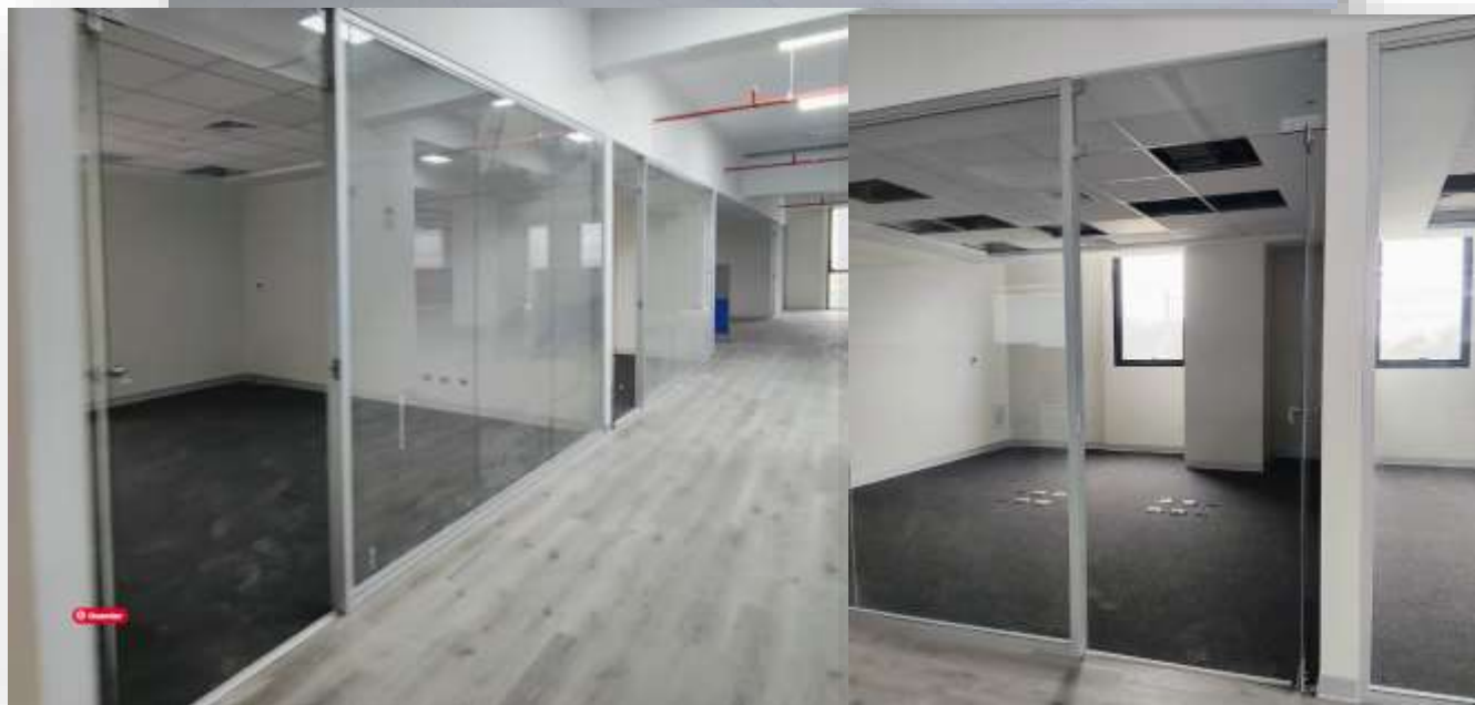
COLOCACIÓN DE MAMPARAS
