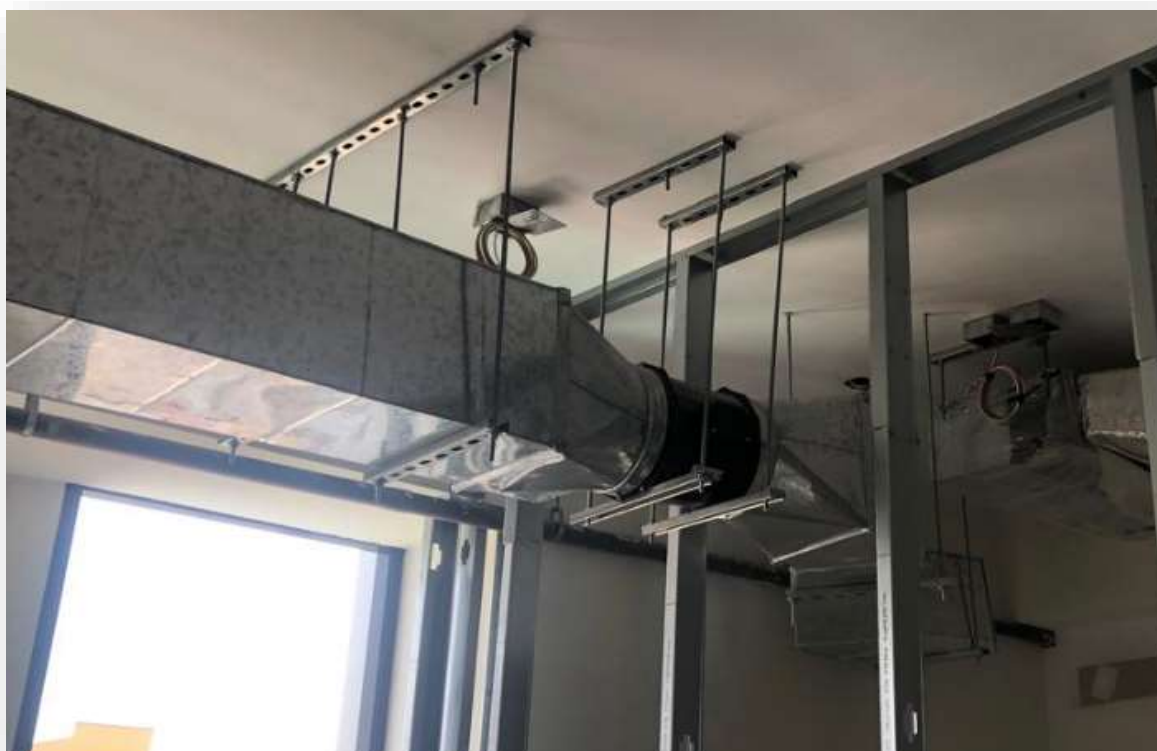
INSTALACIÓN DE INYECTORES EN EL NIVEL 4 Y 5
