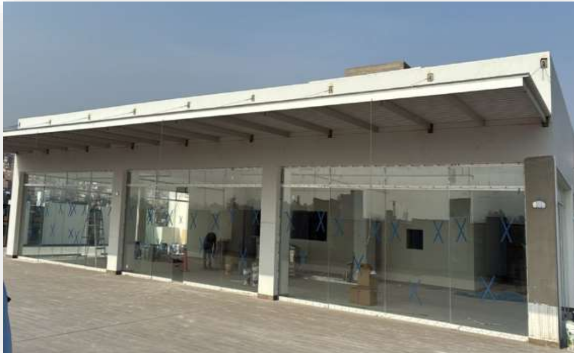
COLOCACIÓN DE COBERTURA SOL Y SOMBRA
