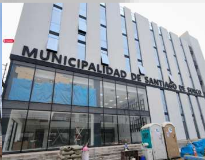
MURO CORTINA SISTEMA STICK CON VIDRIO TEMPLADO INCOLORO E=8MM
