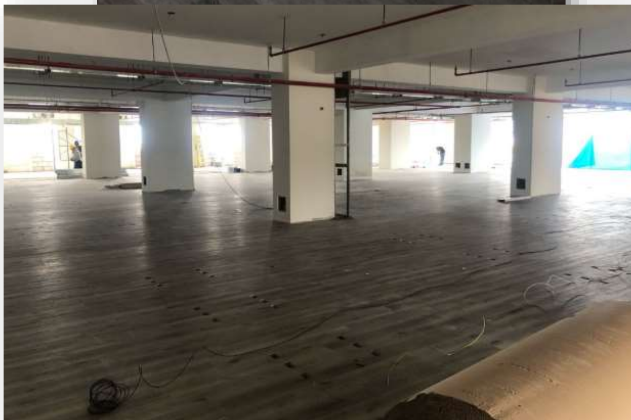
COLOCACIÓN DE PISO SPC
