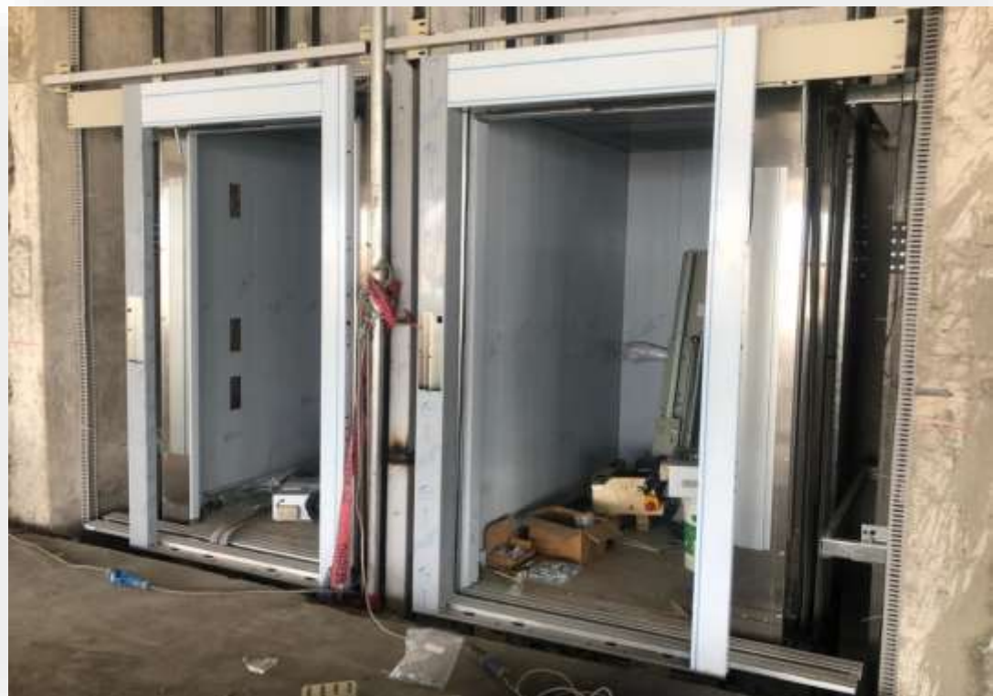
COLOCACIÓN DE MARCOS EN LOS ASCENSORES
