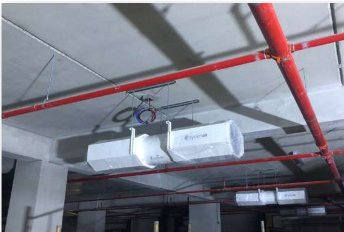
INSTALACIÓN DE JET FAN EN SÓTANO 1
