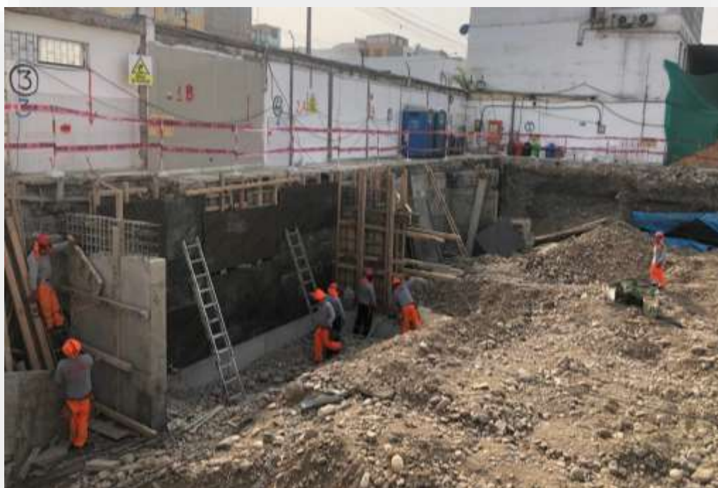
HABILITADO DE ACERO Y ENCOFRADO EN MURO PANTALLA PARA SÓTANO.
